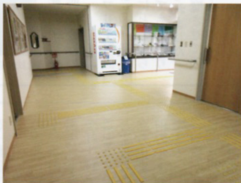
各部屋へと誘導する点字ブロック
